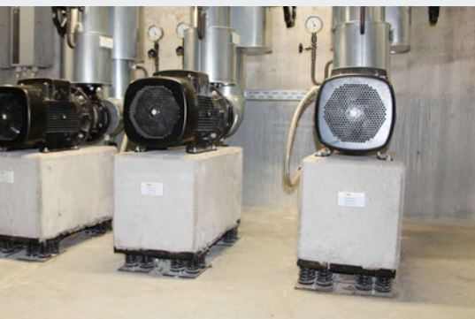
Опора для насосов с использованием стальных пружин Isotop® (блоки изоляторов)
