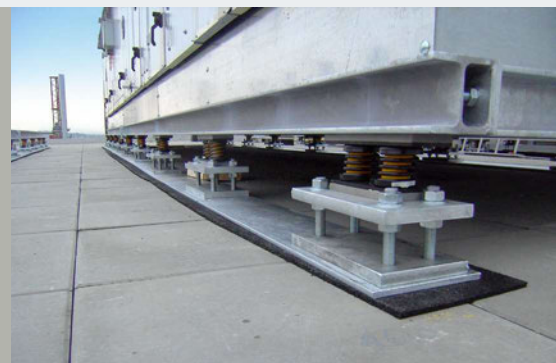
Опора для системы кондиционирования воздуха на стальных пружинах со встроенным демпфером (Isotop® DSD)
