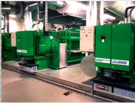
Упругая опора для тепловой электростанции
