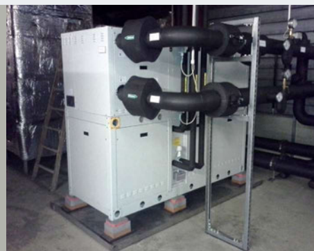
Опора для холодильной машины с использованием Isotop® SE-DE
