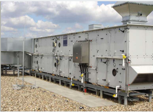
Упругая опора для системы кондиционирования воздуха
